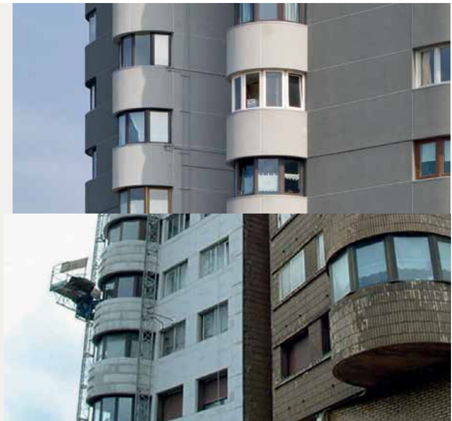
Rehabilitación de fachada Rentería, Gipuzkoa
